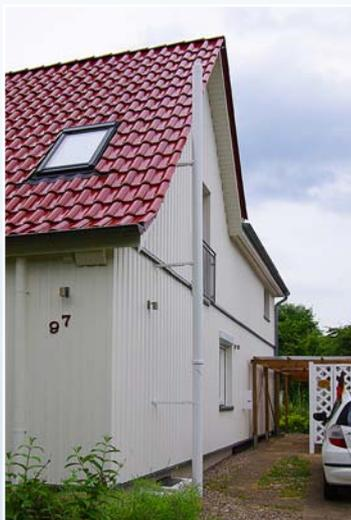
In bestehenden Gebäuden kann sich die Nachrüstung einer Abgasanlage aus Platz-, Baurechts- und Brandschutzgründen als schwierig und kostenintensiv erweisen. Als vorteilhafte Lösung bieten sich hierbei außen angebaute Abgasanlagen mit einer witterungsbeständigen Außenschale aus Edelstahl an. Sie sind zweckmäßig, platzsparend und kostengünstig zu installieren oder nachzurüsten.
